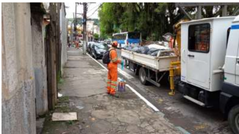
Figura 17 – Pintura de meio fio sendo executada no trecho Nossa Senhora de Santana.
