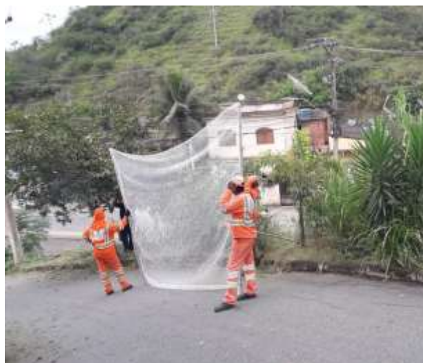
Figura 12 – Roçada sendo executada no trecho Ponte Vermelha.
